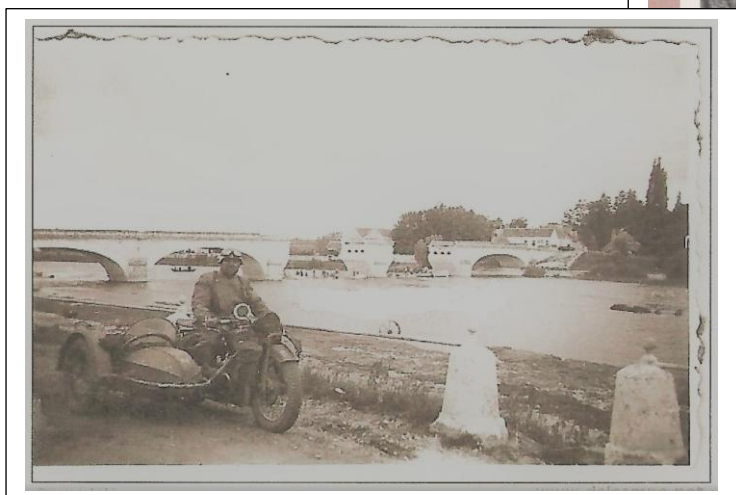
side-car allemand devant le pont avant réparation
